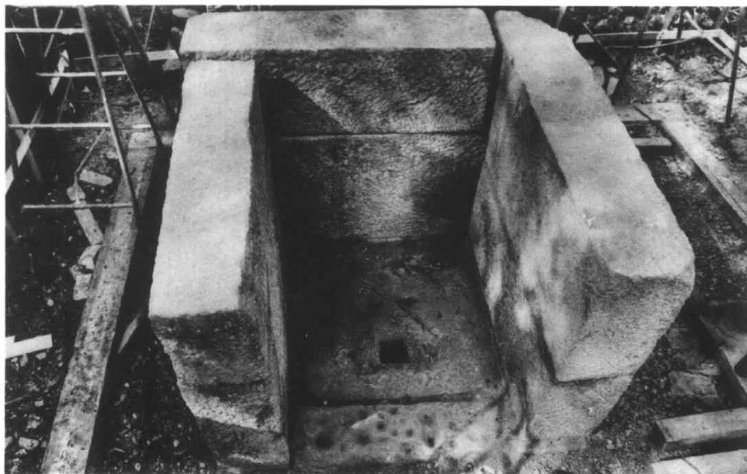
28 屋根石取外し完了
