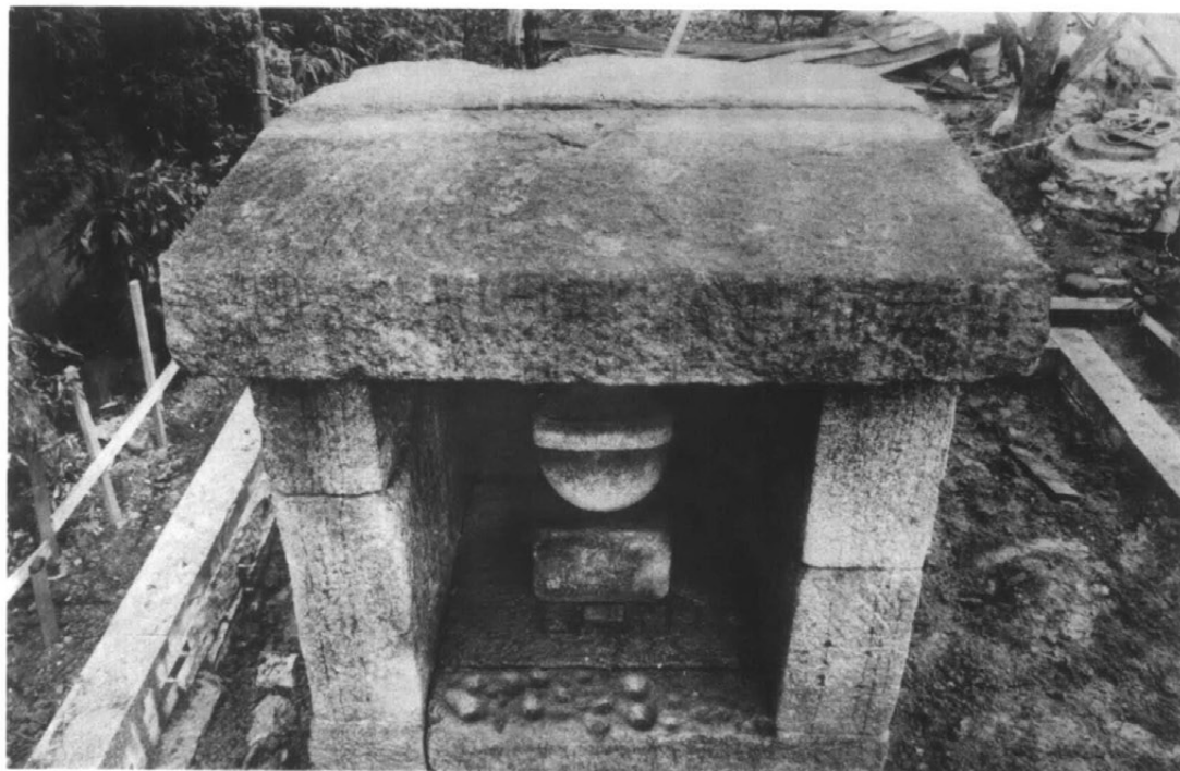
54 屋根石据付完了
