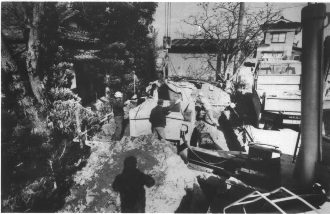
42 コンクリート布基礎据付中
