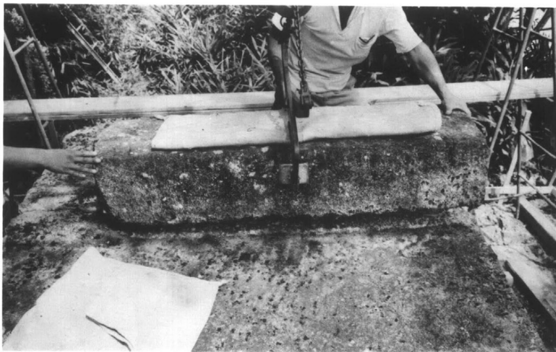
24 棟石取外し中
