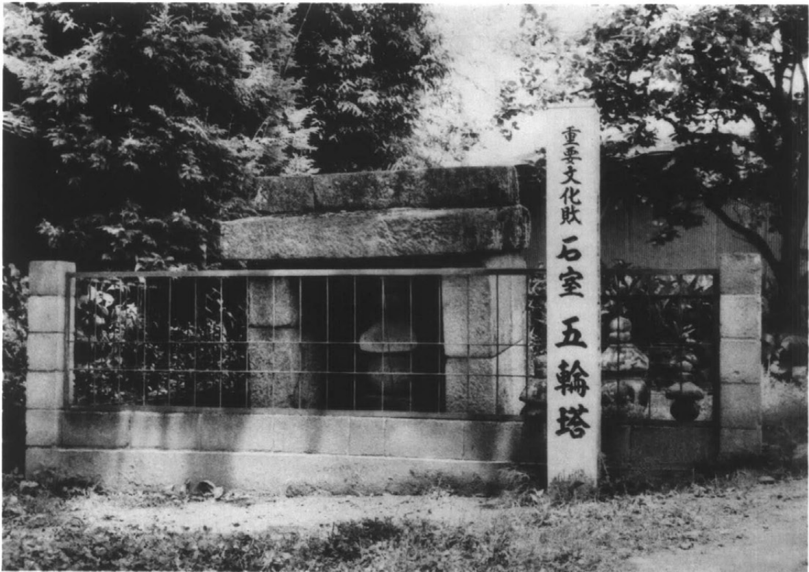
3 修理前 正面（南面）
