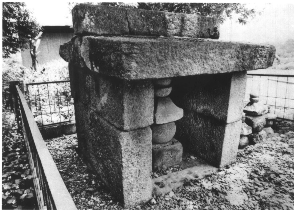
5 修理前 正側面（南西面）
