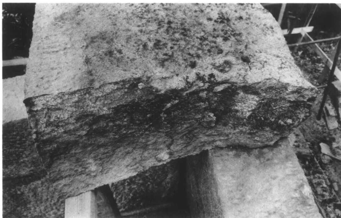
27 屋根石取外し中 (背面西側)
