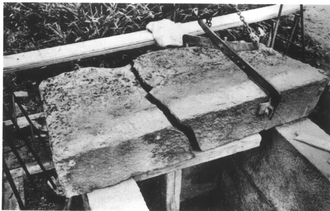
25 屋根石(背面側)取外し中
