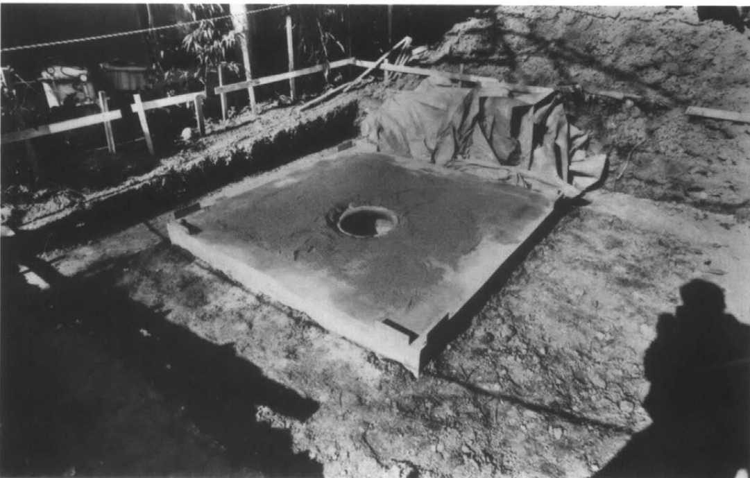
44 同上 据付完了
