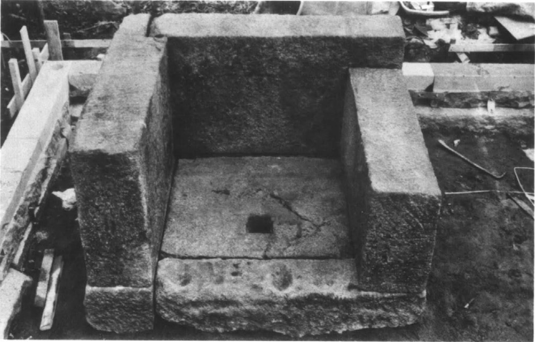
52 壁石積上げ完了(一段)
