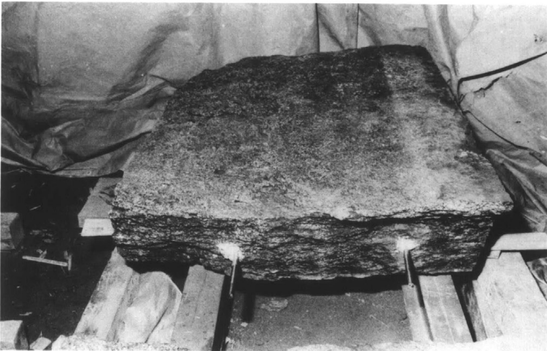
49 屋根石破断面ステンレス筋挿入
