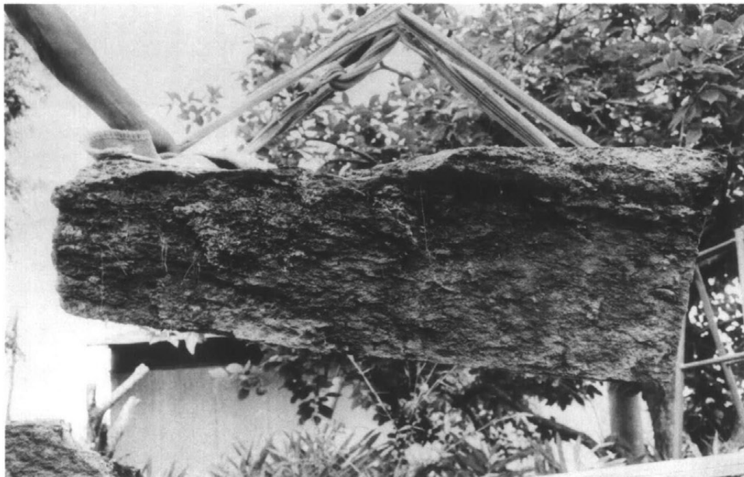
26 屋根石取外し中 (背面東側)
