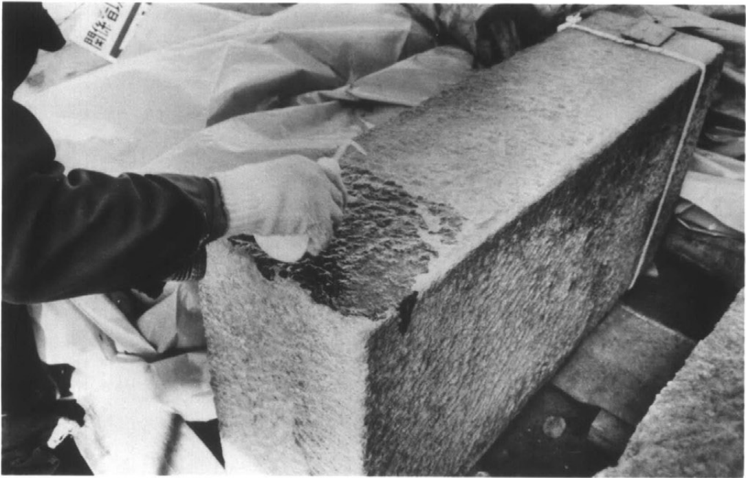
46 防水処理 (SS-101塗布)
