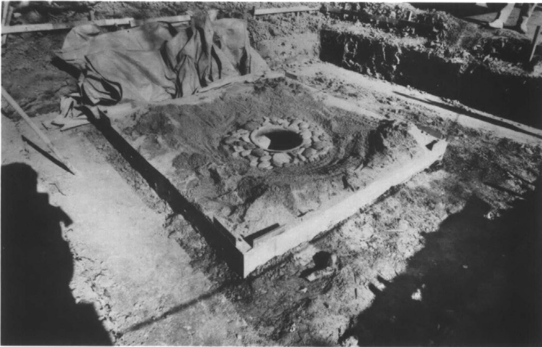
43 骨蔵器据付中
