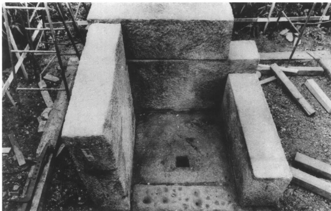
30 壁石取外し中 (手前正面)
