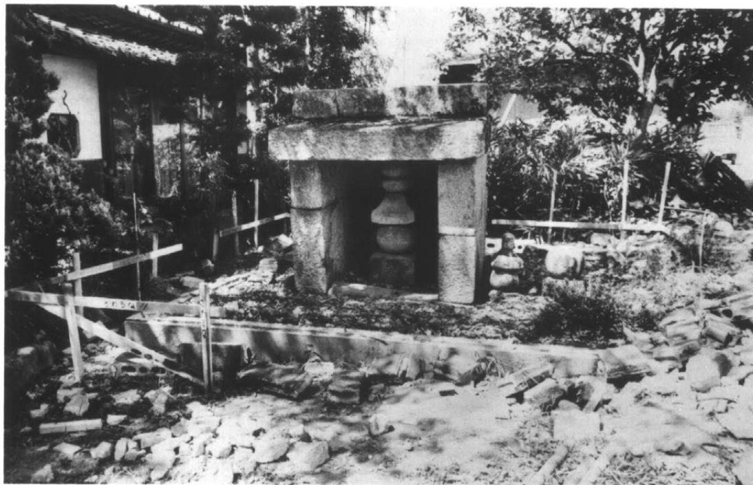
23 保護柵解体中
