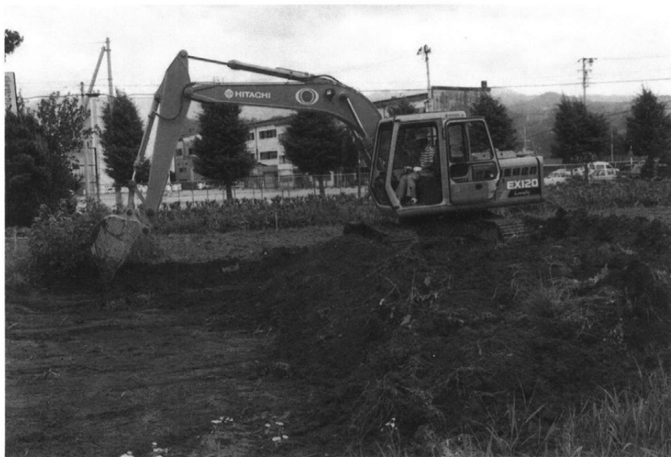
重機作業風景
