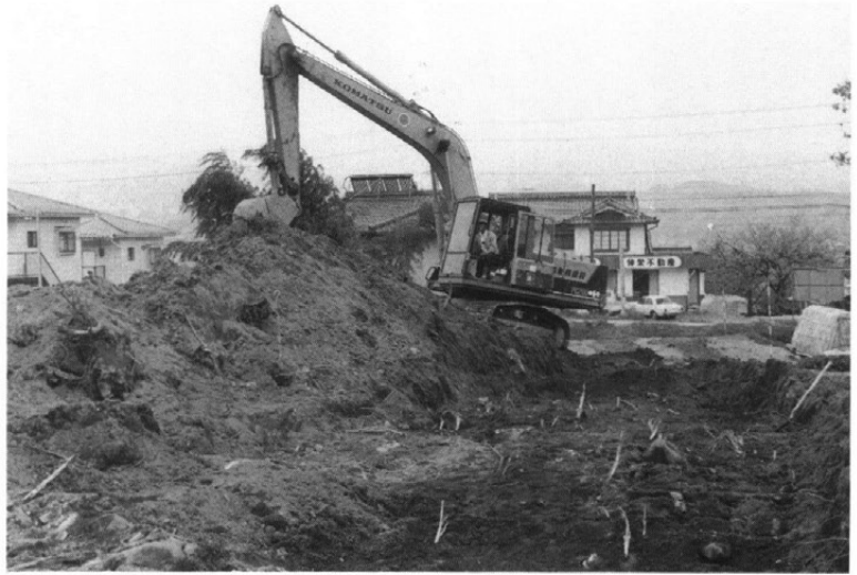
重機による表土剥ぎ
