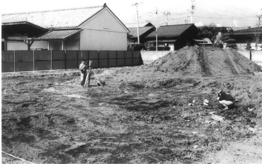
基準点設置作業
