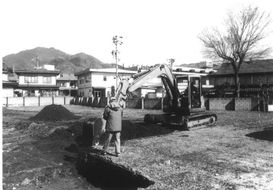
重機作業風景
