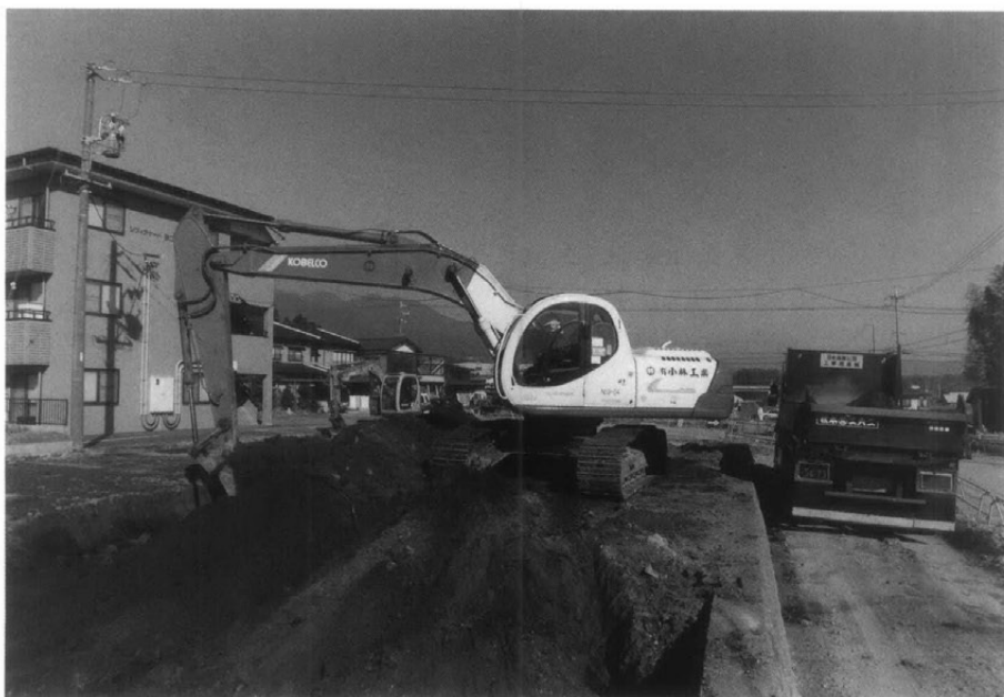
重機表土剥ぎ作業 (1772-1)
