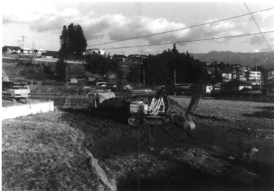
重機表土剥ぎ作業
