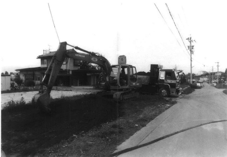
重機表土剥ぎ作業 (1775-6)
