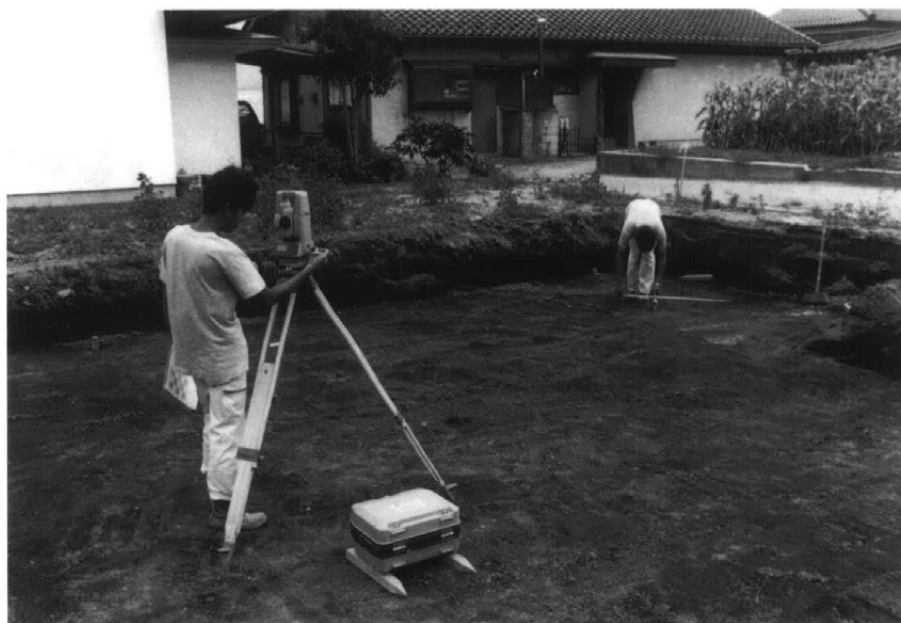
基準点設置作業
