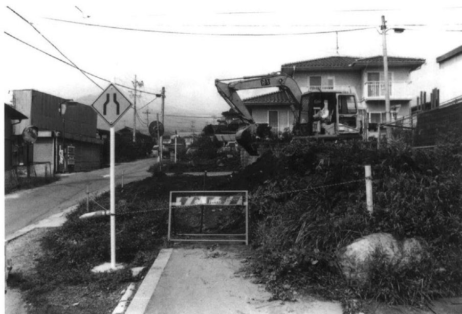
重機表土剥ぎ作業
