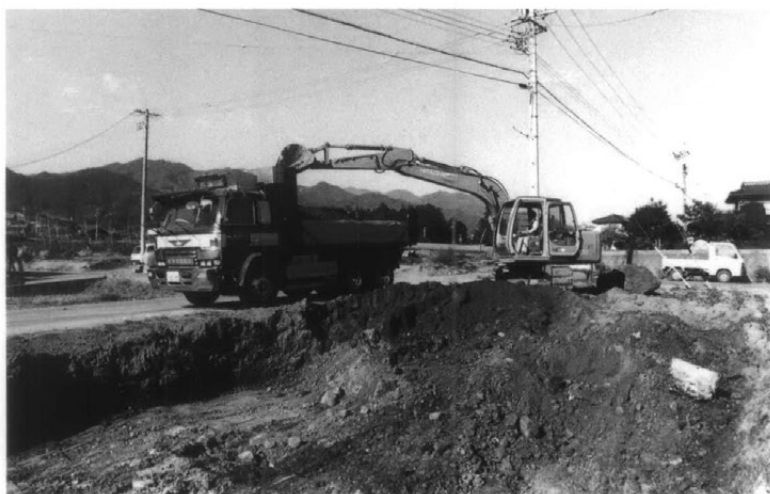
重機表土剥ぎ作業
