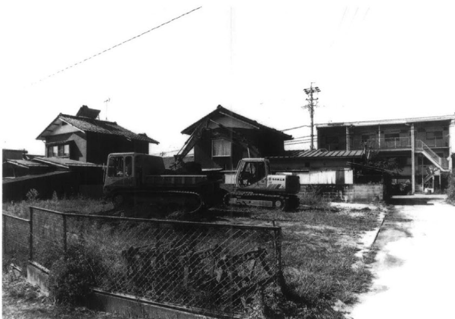
重機表土剥ぎ作業
