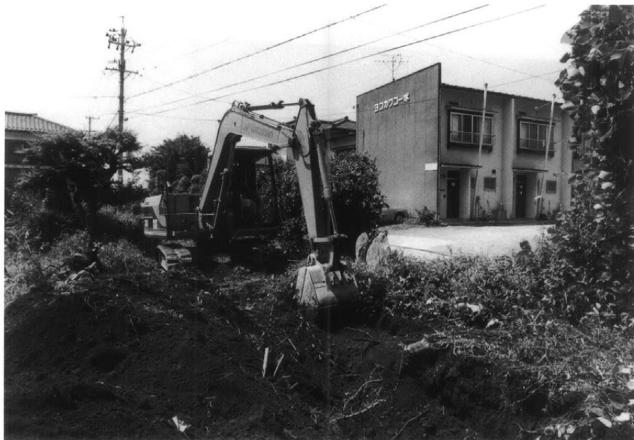
重機表土剥ぎ作業 (1778-1)
