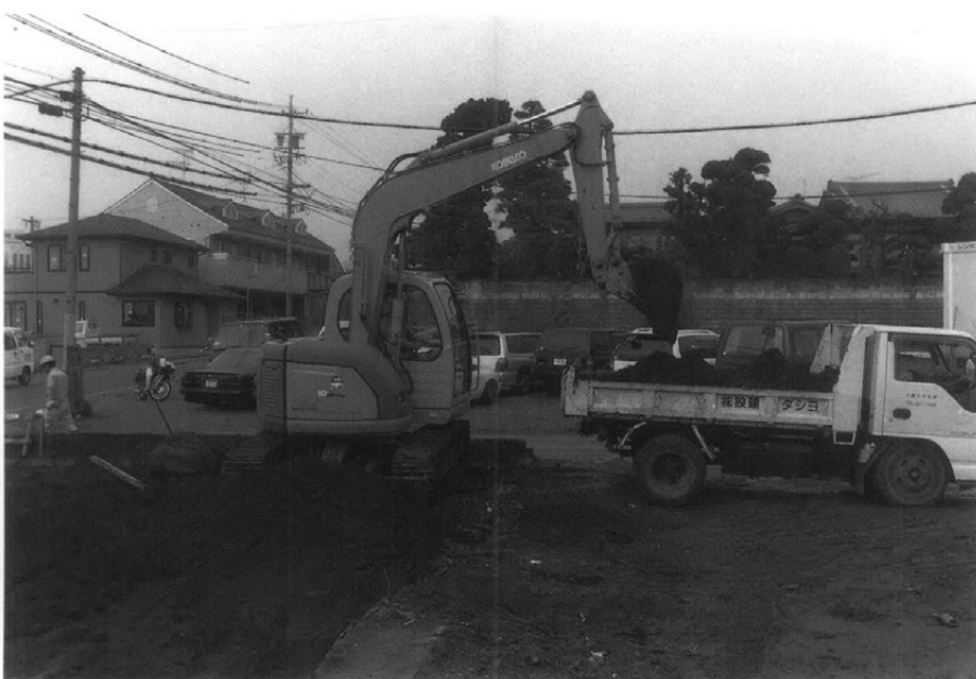
重機表土剥ぎ作業
