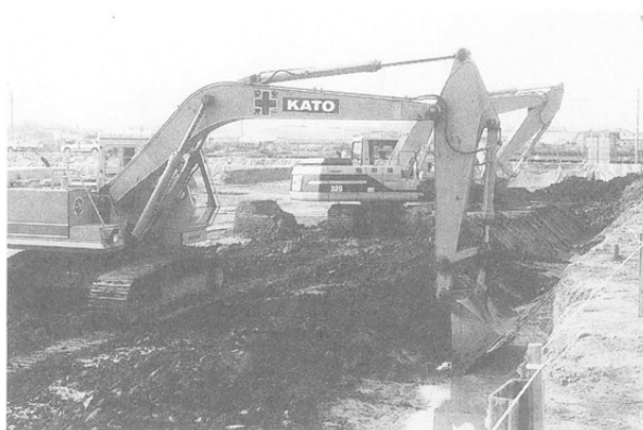
外周トレンチの掘削（更埴条里遺跡J地区）
