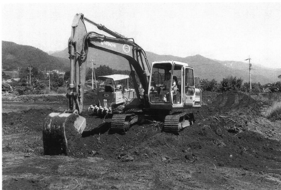
富士塚遺跡重機作業風景
