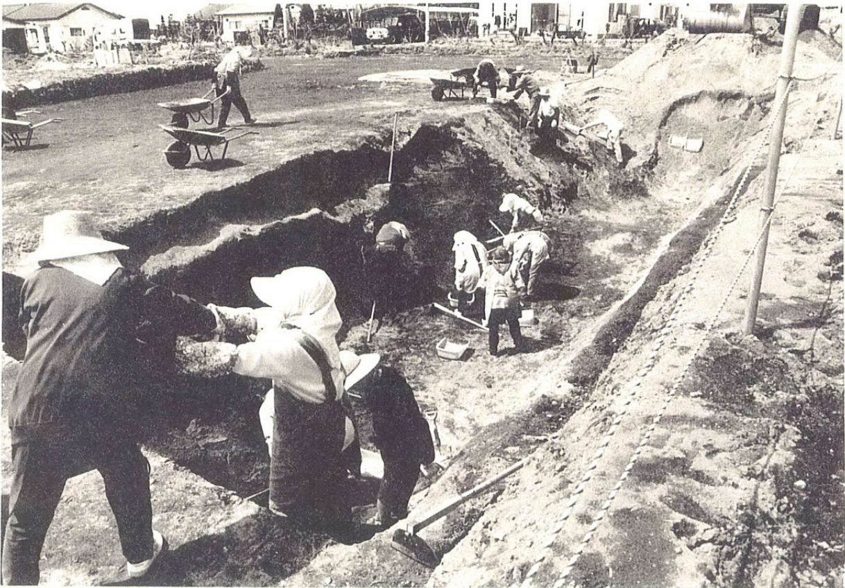
太平洋戦争中に構築された津上製作所信州工場の地下工場
