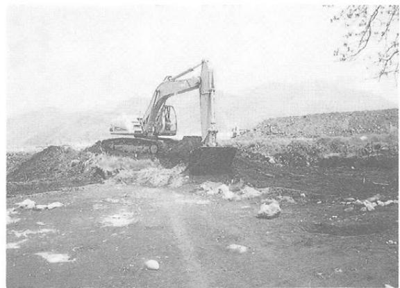
バックホーによる表土剥ぎ作業
