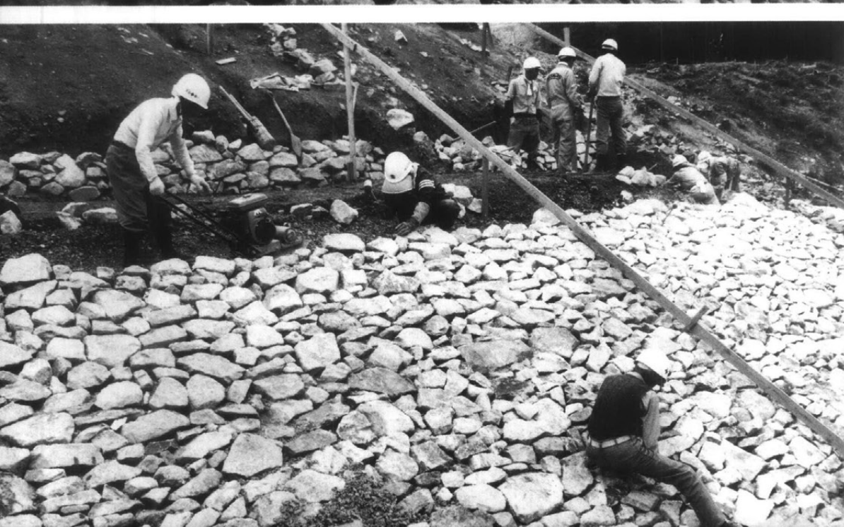
タコ・ランマーによって締め固められる葺石下地 (西側斜面北から)
