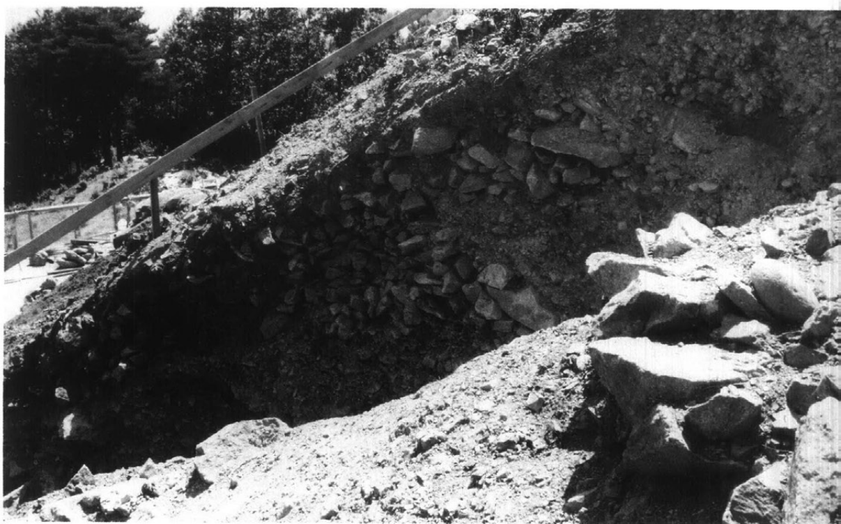
三角形の盛土 (Ⅲトレンチ、西北西から)
