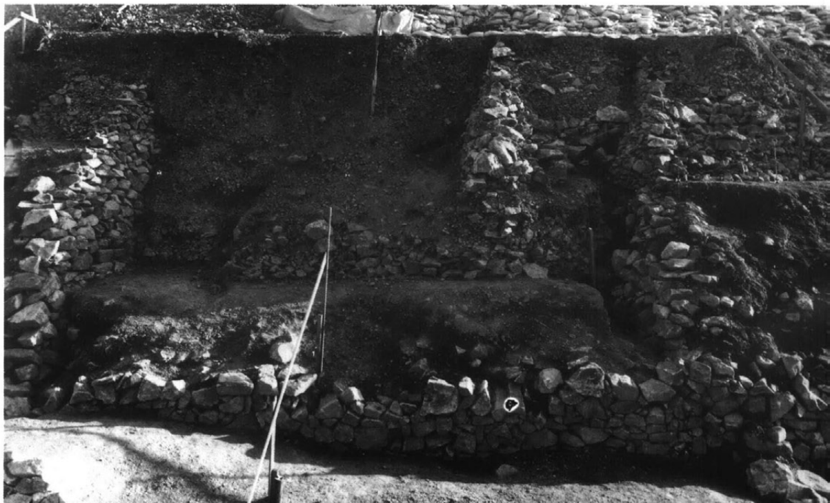
中段石垣 1・2次縦方向石積み 「」・しと相対する (西側斜面中程、西から)
