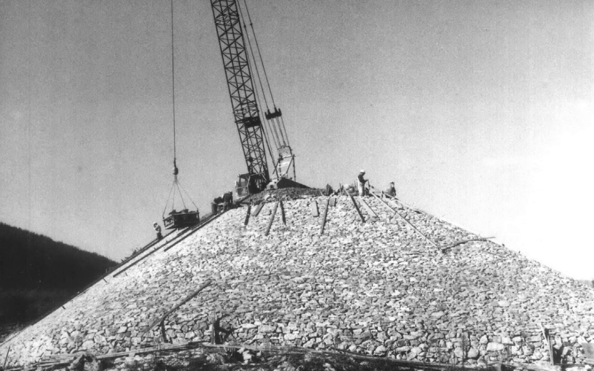
墳頂に設置されたクレーンによる資材の搬入 (東から)
