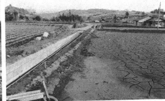
工事終了後の遺跡（北から）
