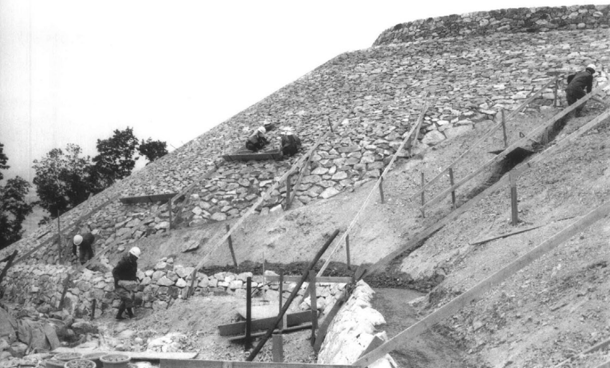
西側くびれ部 後円部墳丘施工後、前方部 施工 (南西より)
