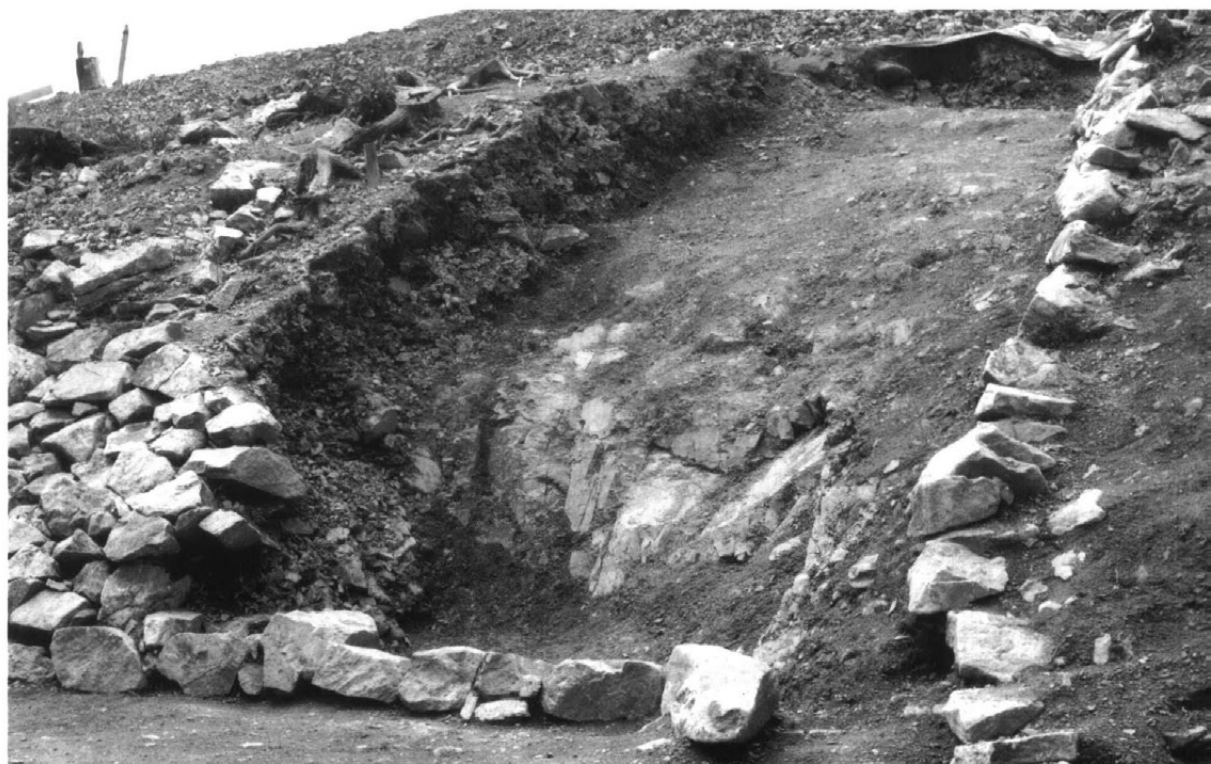
岩盤を削り残し、くびれ部 を成形 (東より)
