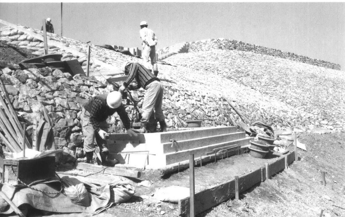
前方部東側 見学者用の階段設置 (南より)
