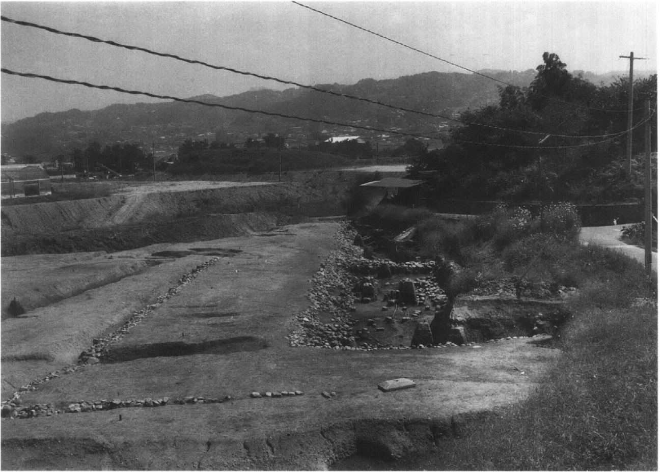
第Ⅱ期内側周溝内壁の石積崩落状況（西から）
