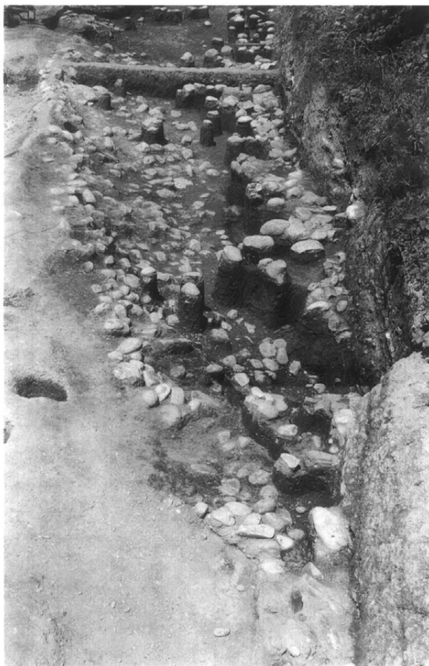
墳丘南側 第Ⅱ期内側周溝内壁の石積崩落状況
