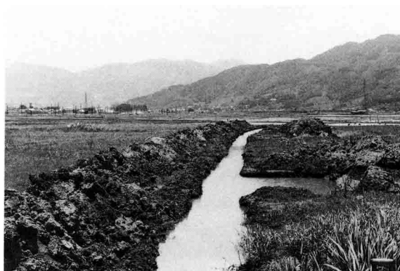
水没した試堀坑
