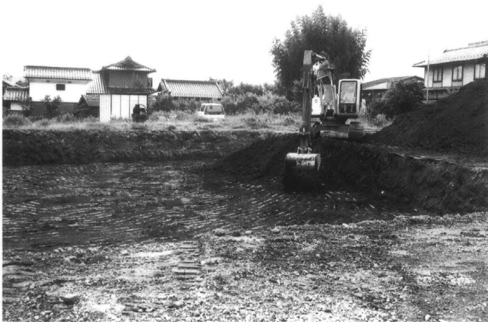
重機作業風景
