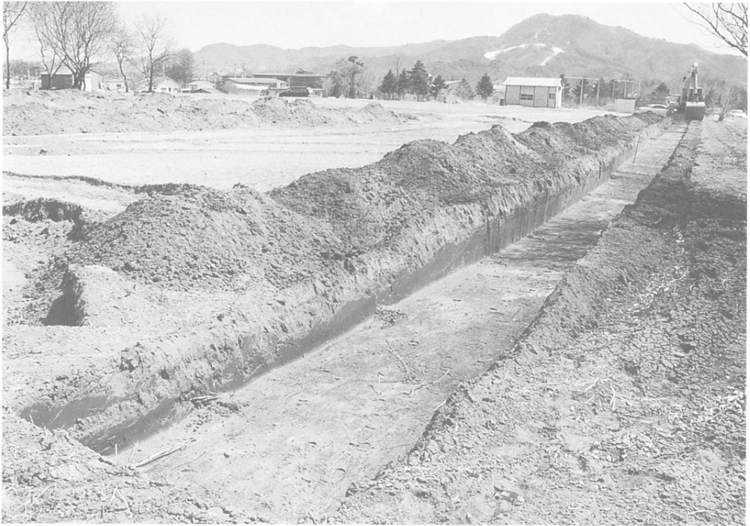
写真 16 聖原Ⅱ遺跡トレンチ掘削状況
