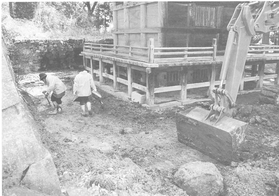
写真 19 三重塔北側調査風景
