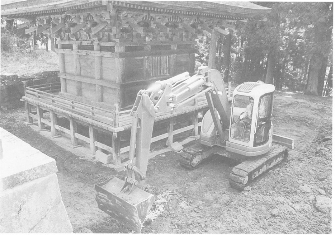
写真 21 三重塔周囲調査風景
