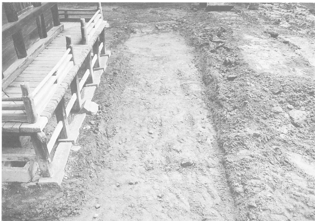
写真 23 三重塔北側トレンチ
