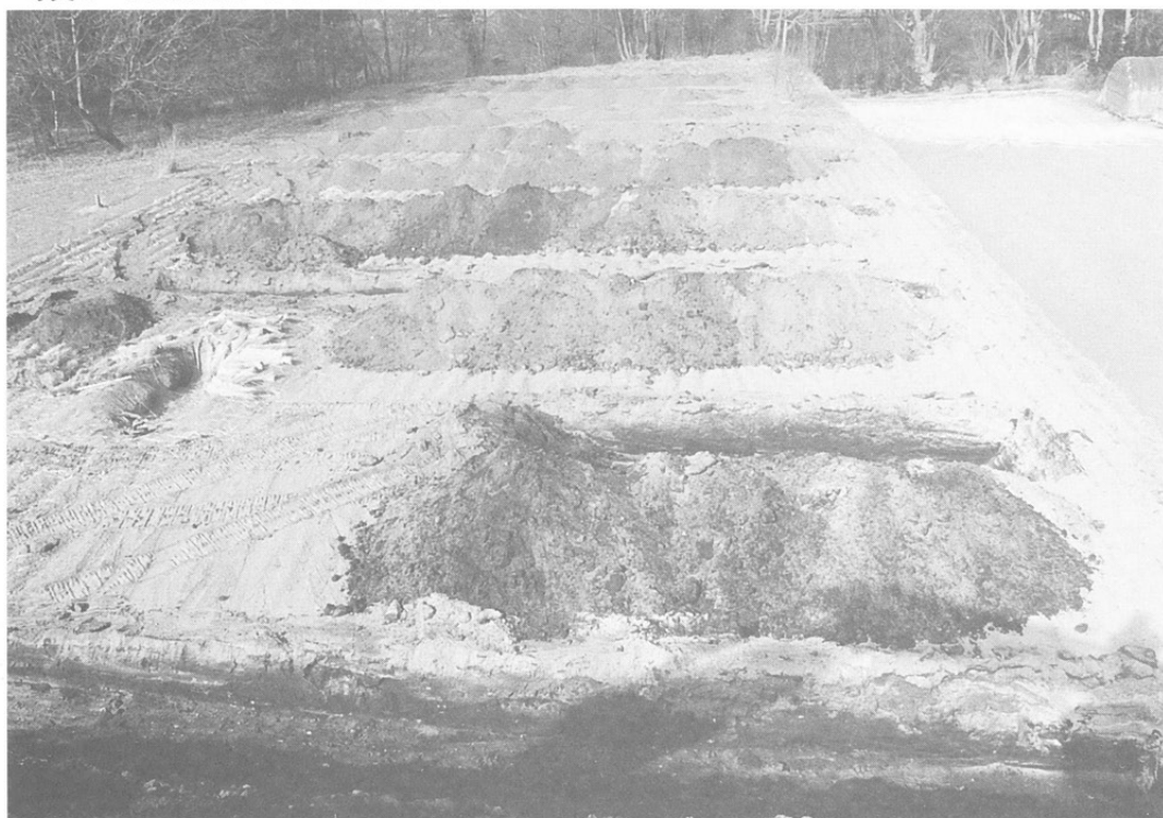
写真4 調査地区トレンチ掘削状況
