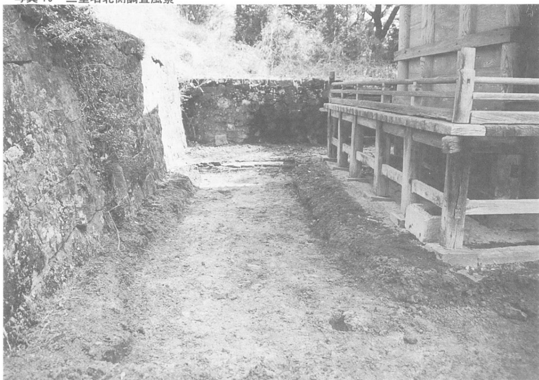
写真 20 三重塔北側トレンチ
