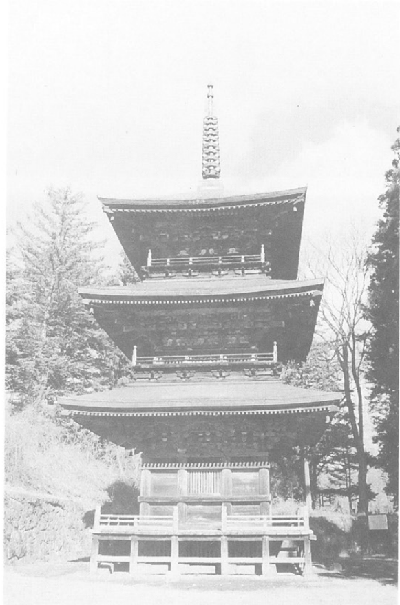
写真 17 真楽寺三重塔
