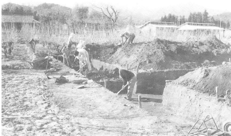
トレンチ掘り下げ作業
