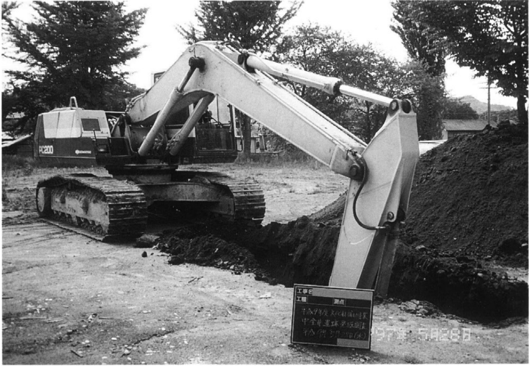
写真2 試掘坑1 掘削風景
