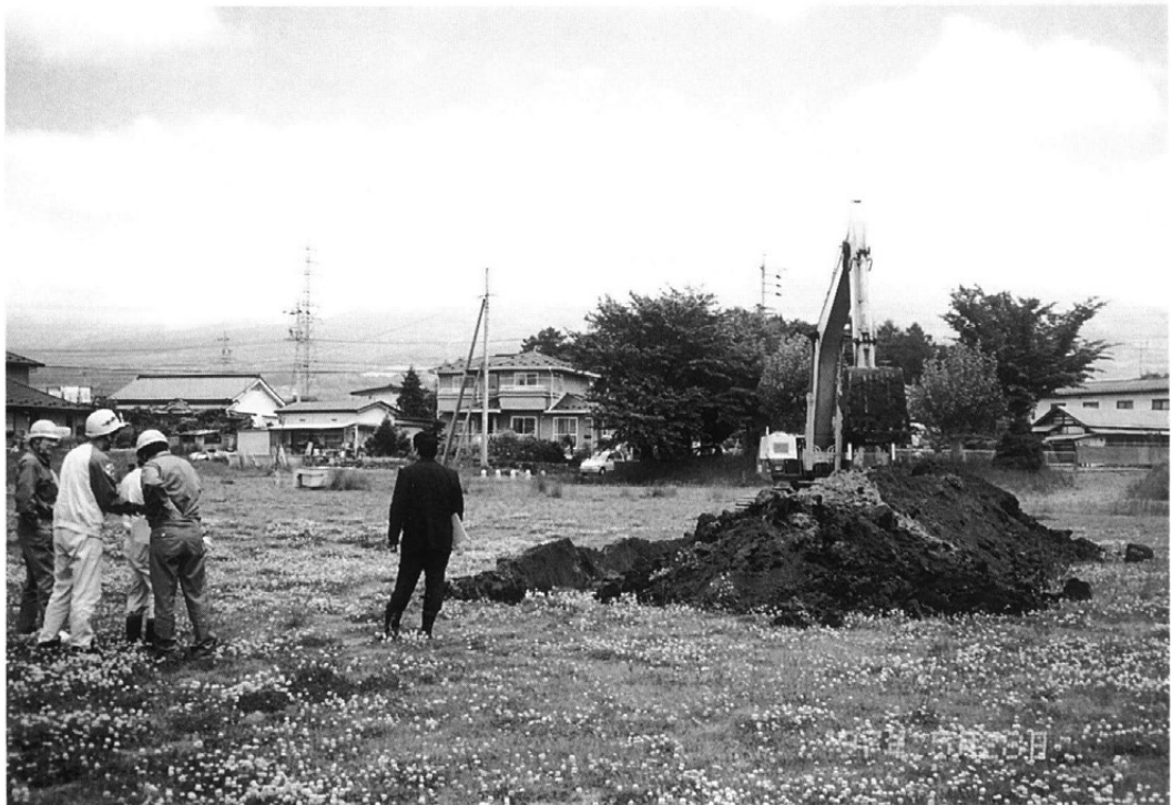
写真3 試掘坑2 掘削風景
