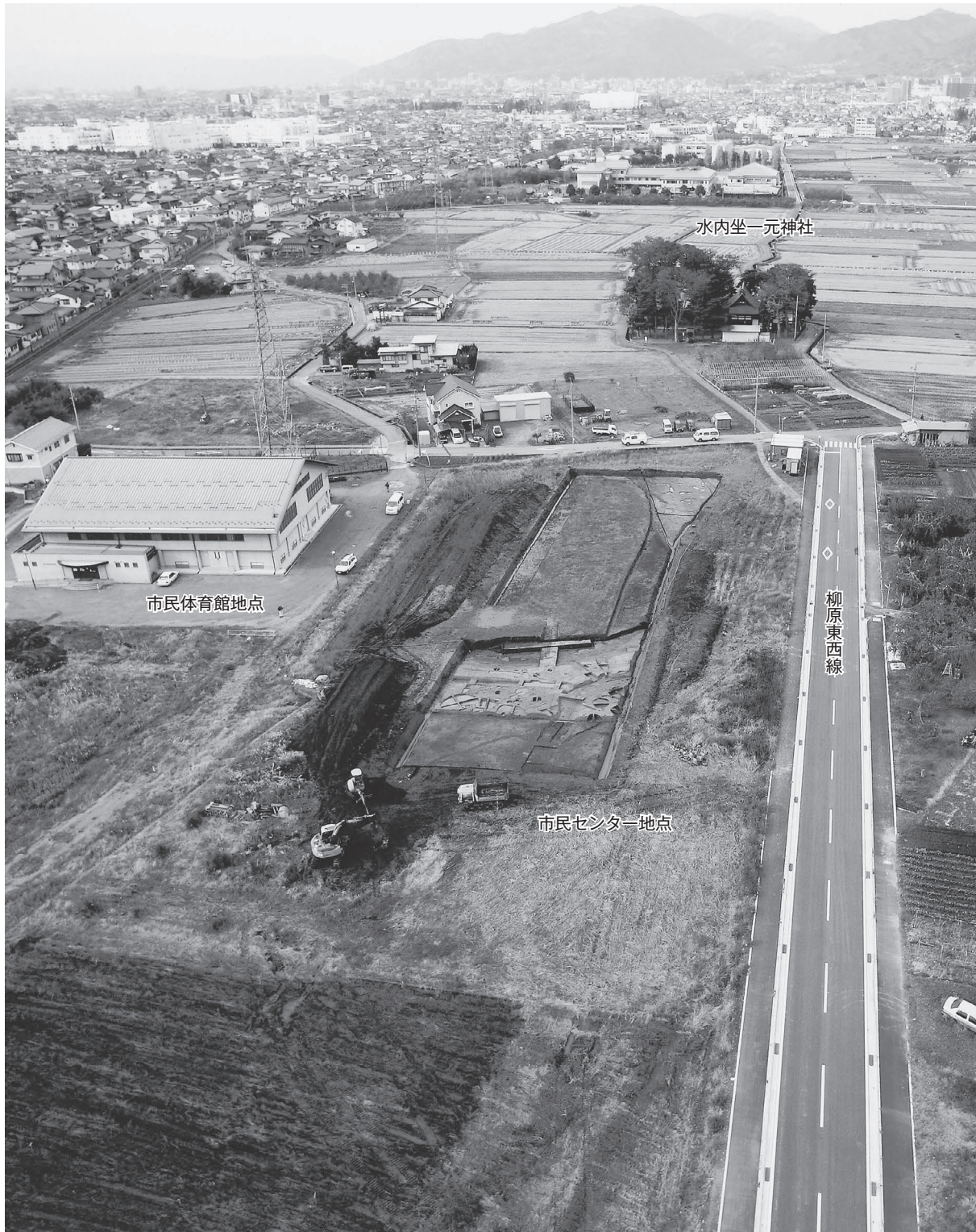
発掘調査地周辺の空中写真（東より）
