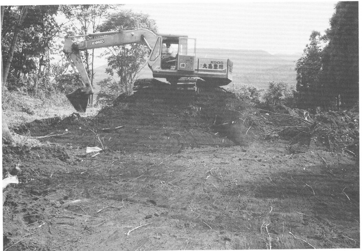
▲ 重機による表土はぎ
