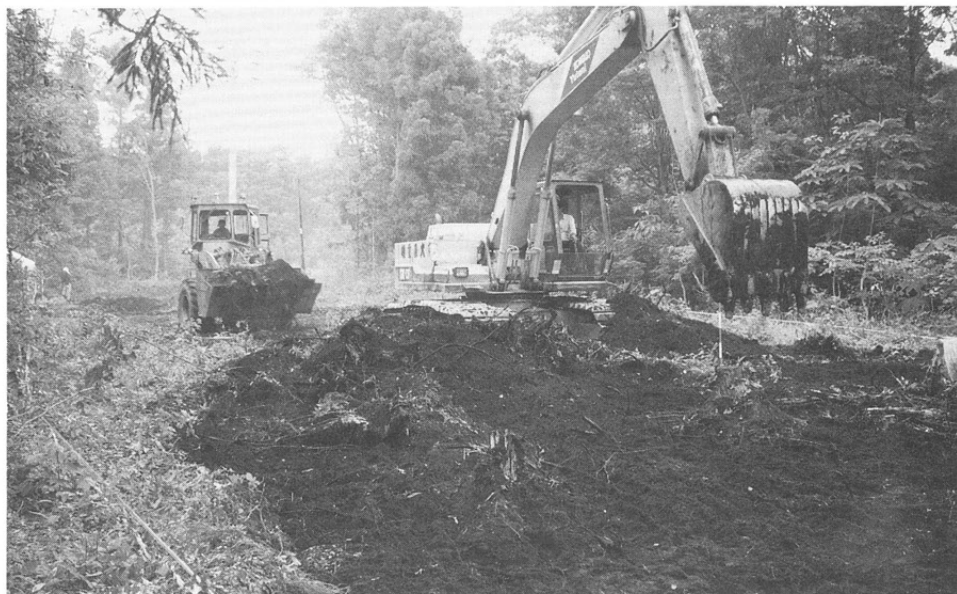
◀ 重機による表土除去
