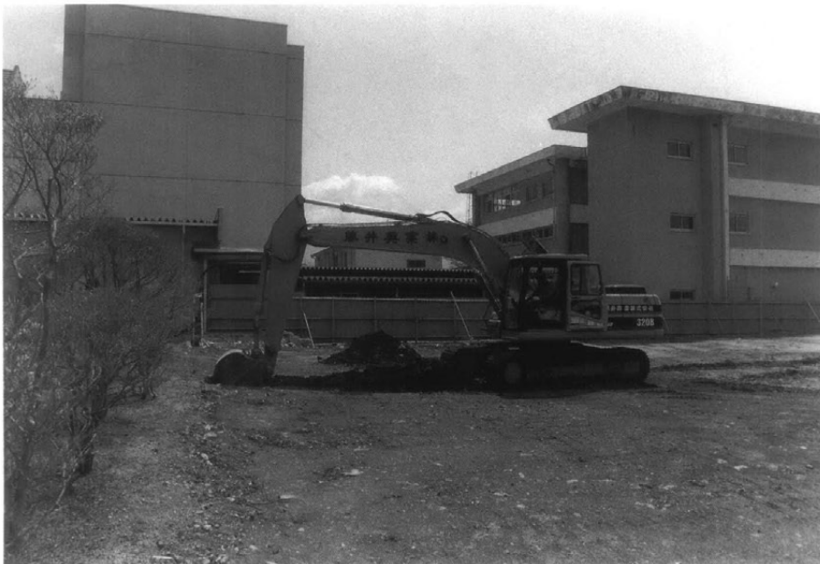
重機作業風景
