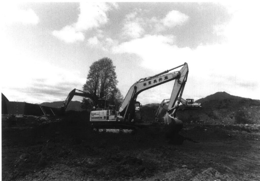
重機作業風景
