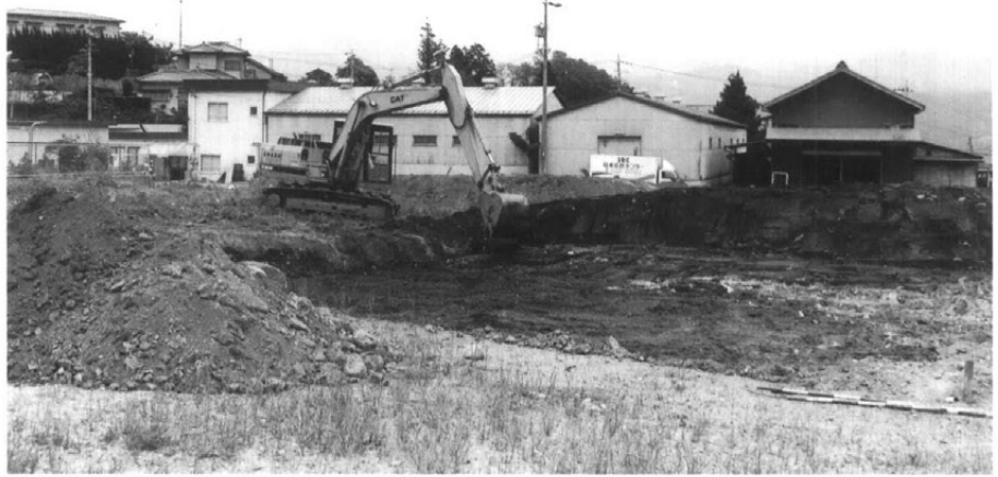
重機作業風景
