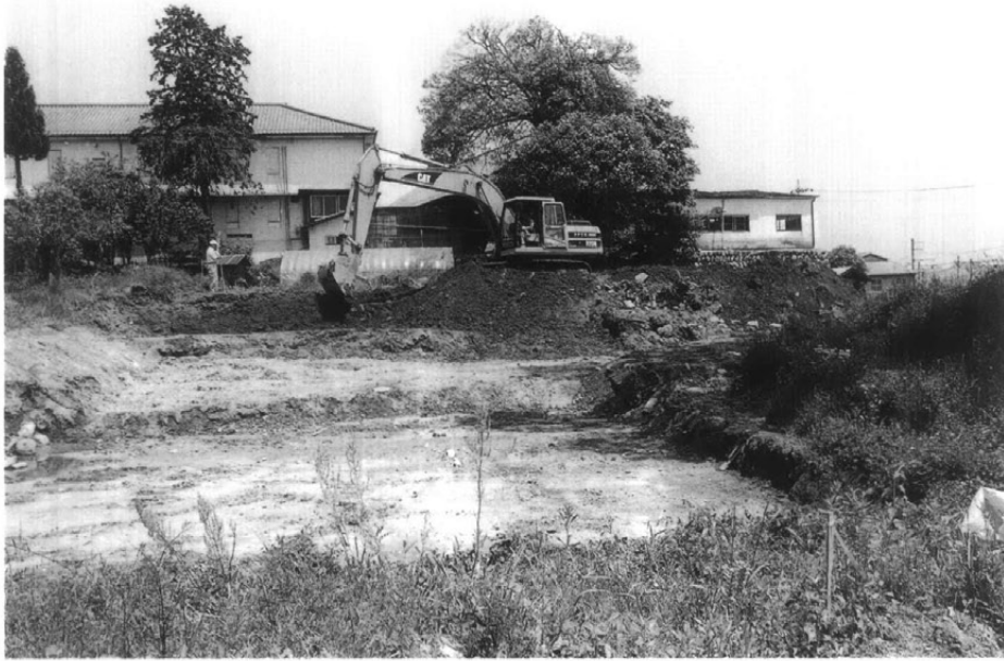
重機作業風景
