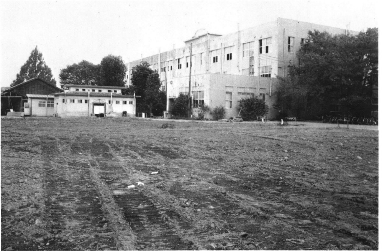
校舎建設用地—特別教室を撤去したあと—東より
