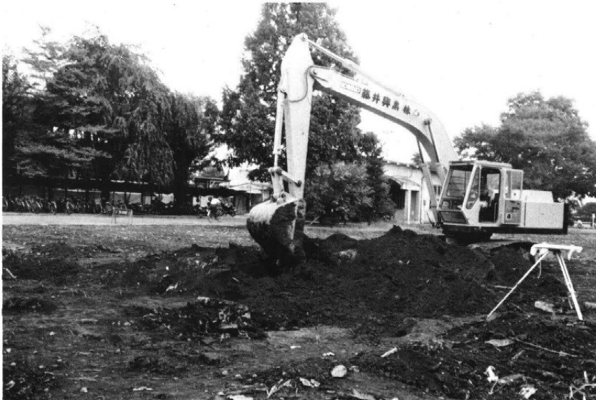
重機により表土排出
