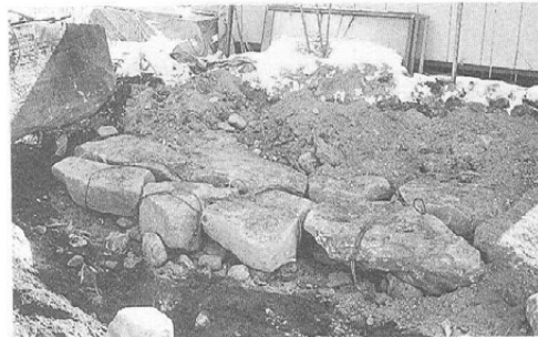
石の除去状況
