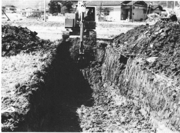
重機による トレンチ掘り (ZAPP21)
