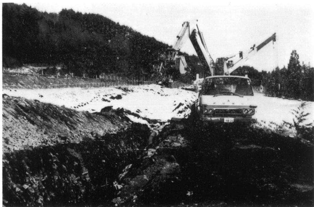
工事実施中の遺跡地
