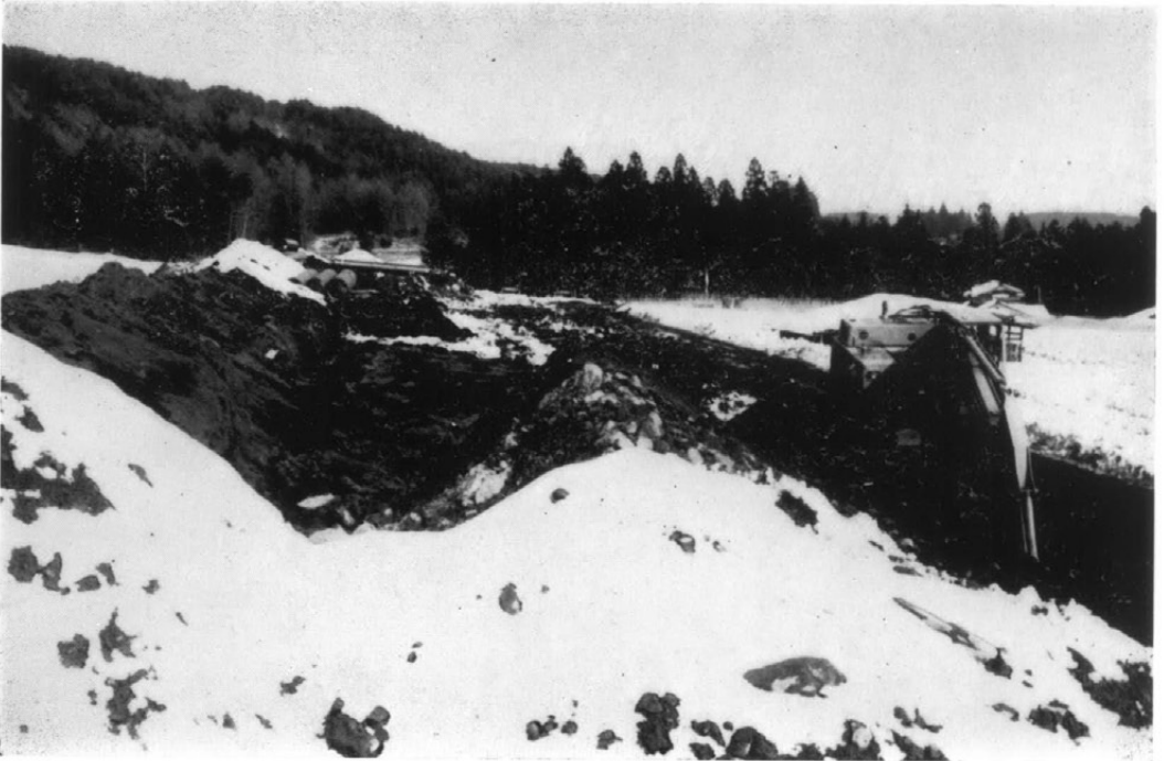
工事実施中の遺跡地
