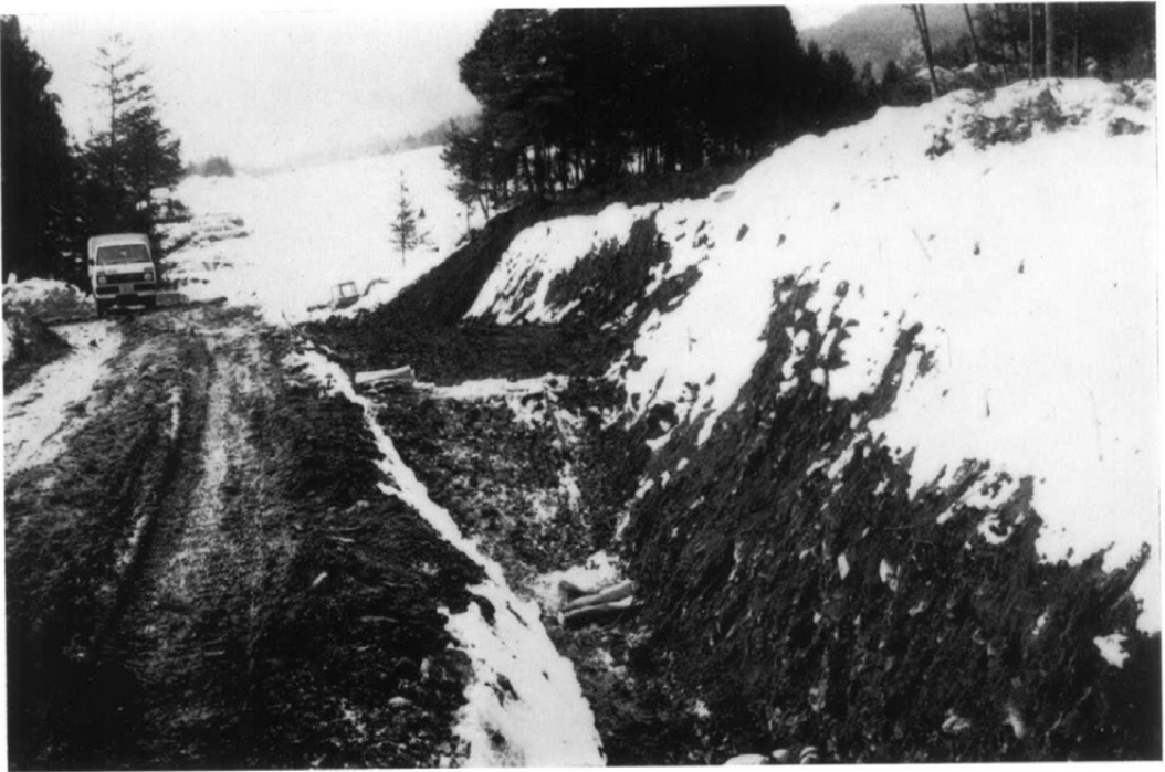
工事実施中の遺跡地
