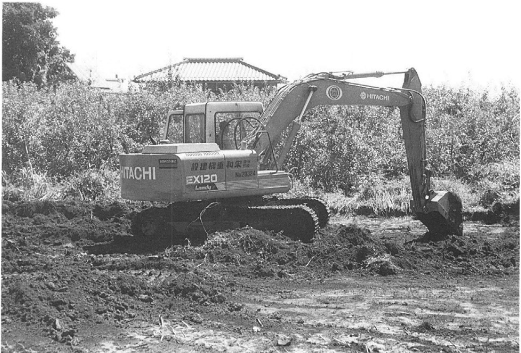
重機作業風景
