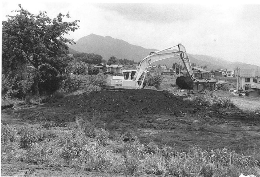
重機作業風景
