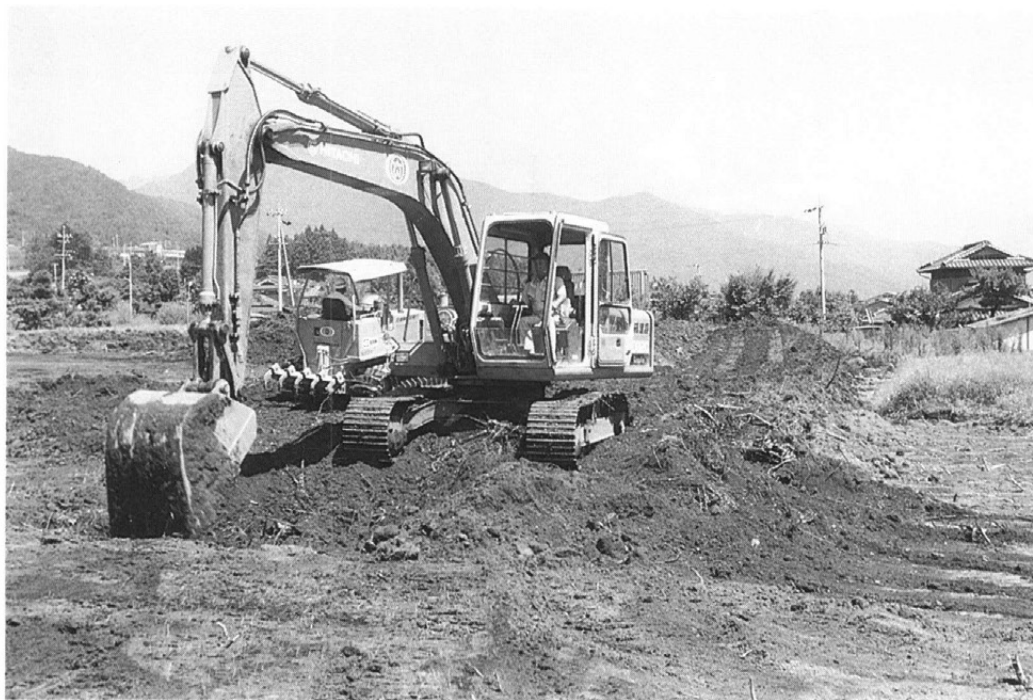
重機作業風景
