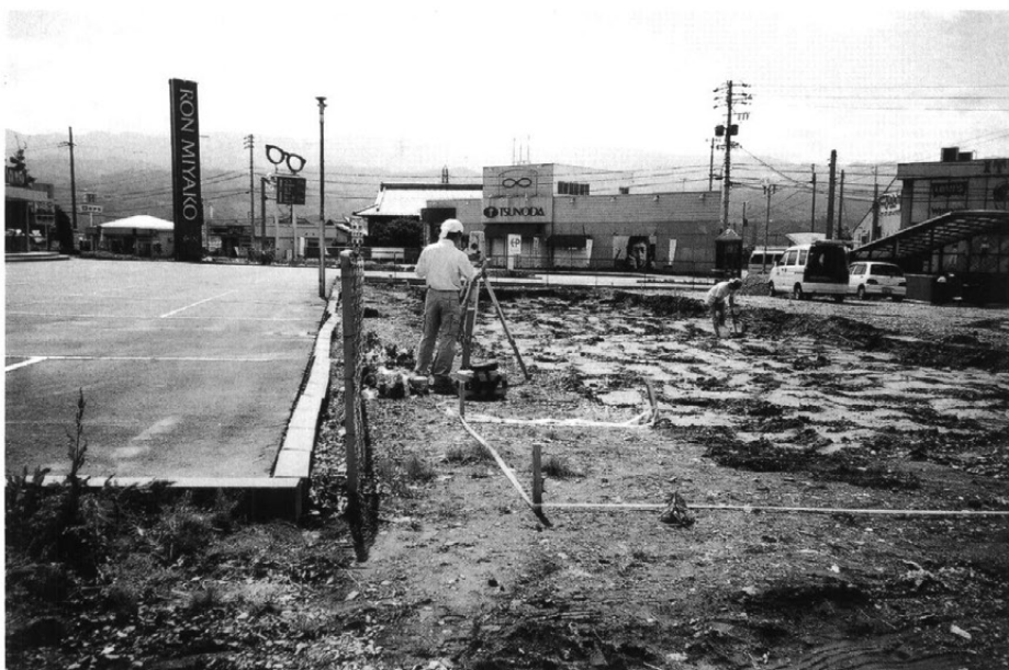
測量作業風景
