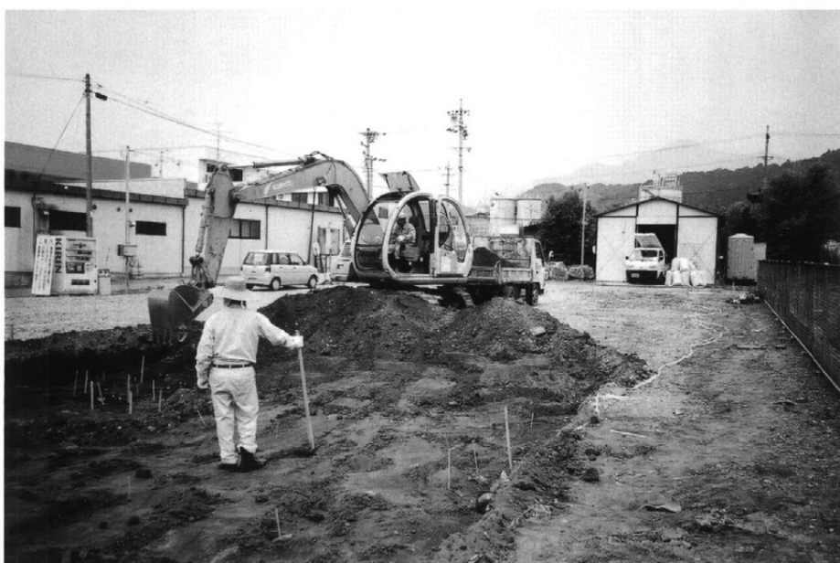
重機作業風景
