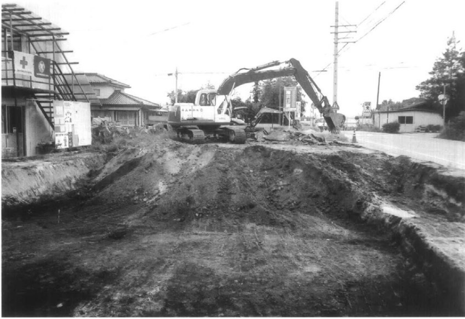
重機作業風景
