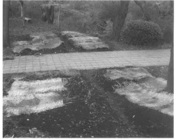
44 南曲輪埋め戻しの様子
