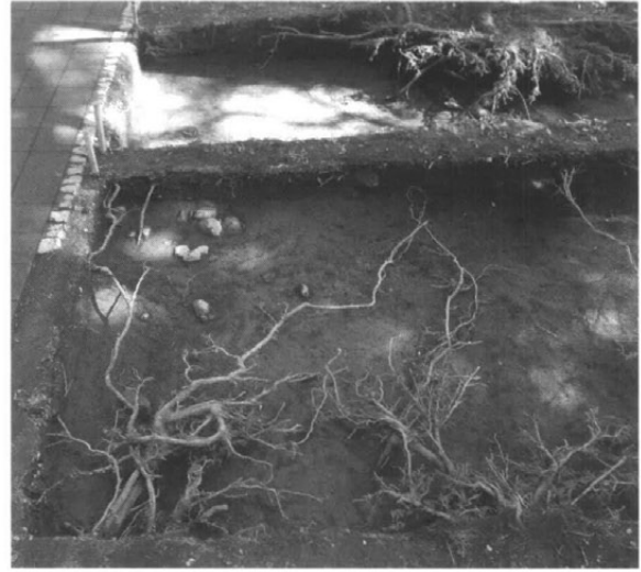
38 4-2区桜の根の状況（西から）
