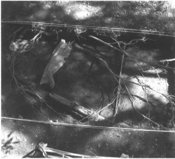
25 2-5区土管、電気ケーブルの状況（西から）
