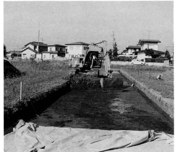
重機表土剥ぎ
