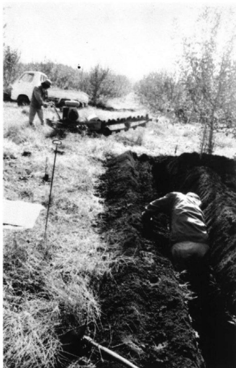
狭い溝の中の調査
