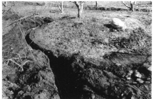
赤坂古墳の西側に配管溝が掘られる—右下に羨道部とみる敷石が発見され、さらに溝は西に迂回する
