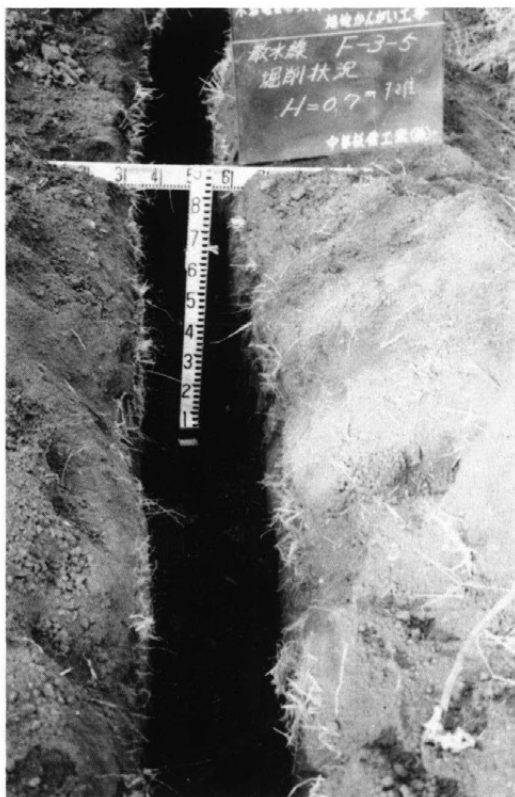
配管溝の幅と深さ
