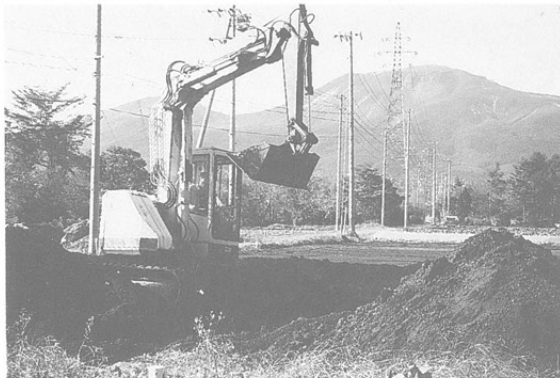
県遺跡A区表土はぎ
