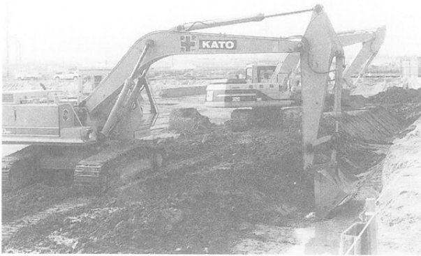
外周トレンチの掘削（更埴条里遺跡J地区）
