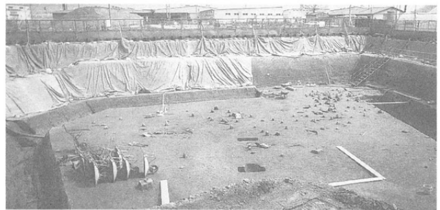
排水用トレンチ、法面シート、階段と手すり
