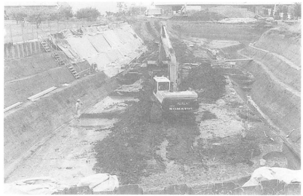
XV層(縄文中期前葉)までの掘削 (⑤a区)
