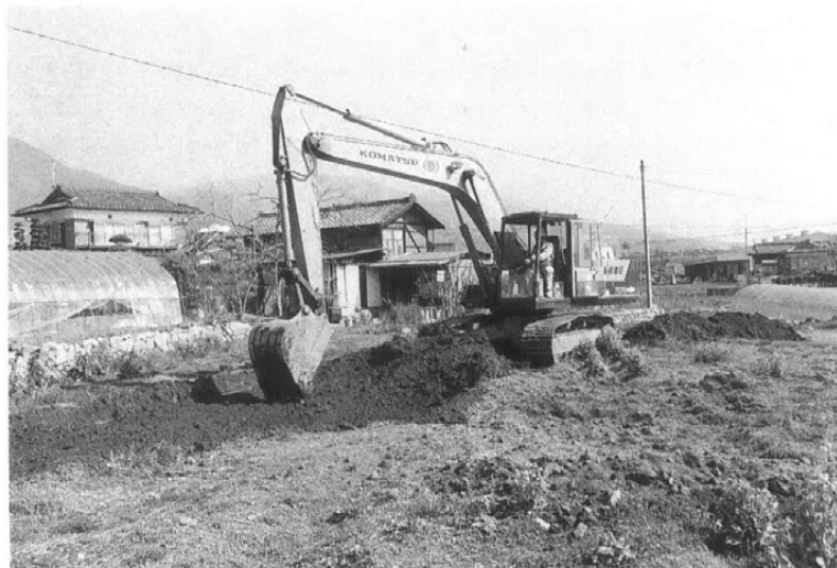
重機作業風景
