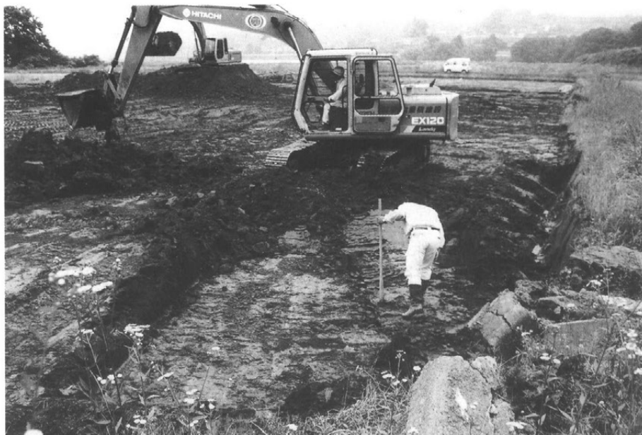
重機作業風景
