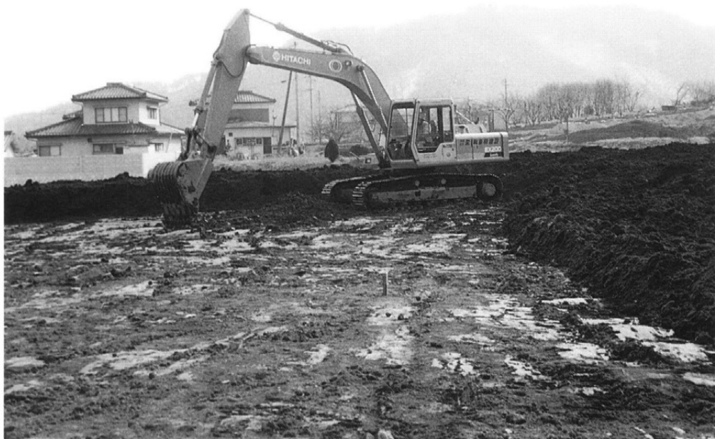
重機作業風景
