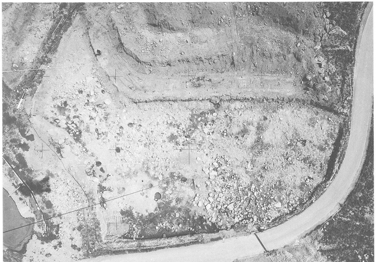
ダンプ道部分 航空写真
