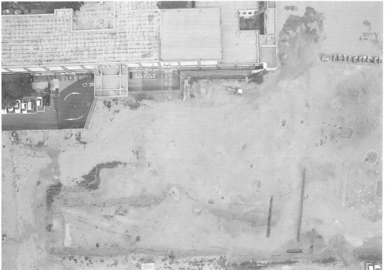
調査地区全体写真（西半分）
