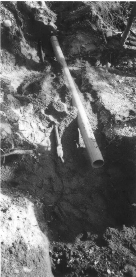
管路第1トレンチ配石No.1 (砂入れ後污水管は遺構上を通す)
