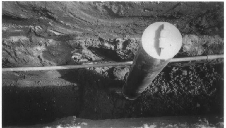
管路第2トレンチ (NTT管に沿って污水管埋設)
