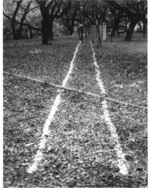
管路第1トレンチ
