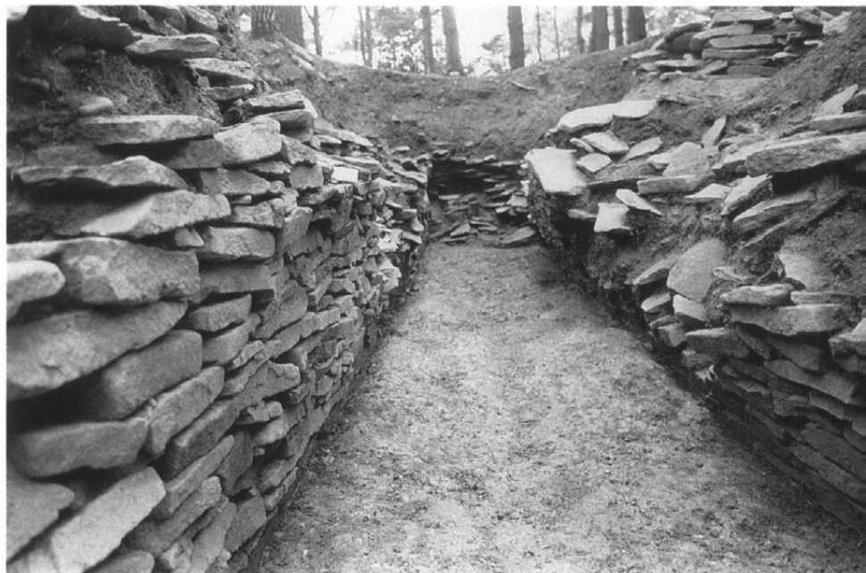
竪穴式石室内部 (前方部側より)
