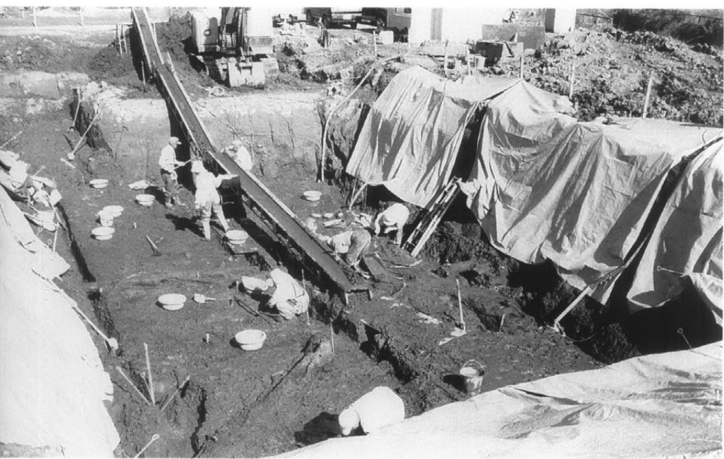
深掘り部分 (南側より)
