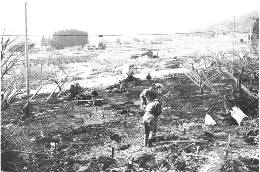
火振原遺跡調査風景
