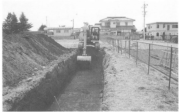
写真2 トレンチ調査
