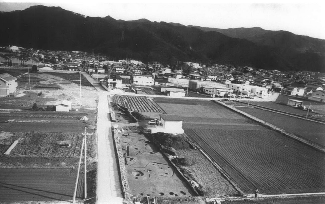
C地区西側全景 (西側より)
