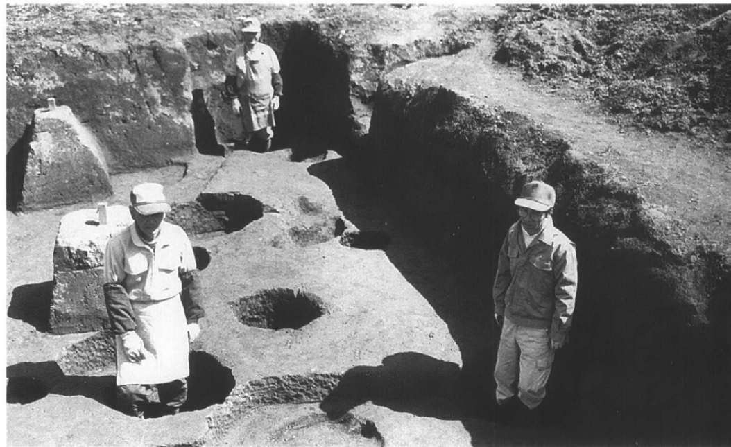
11号掘立柱建物跡 (西側より)
