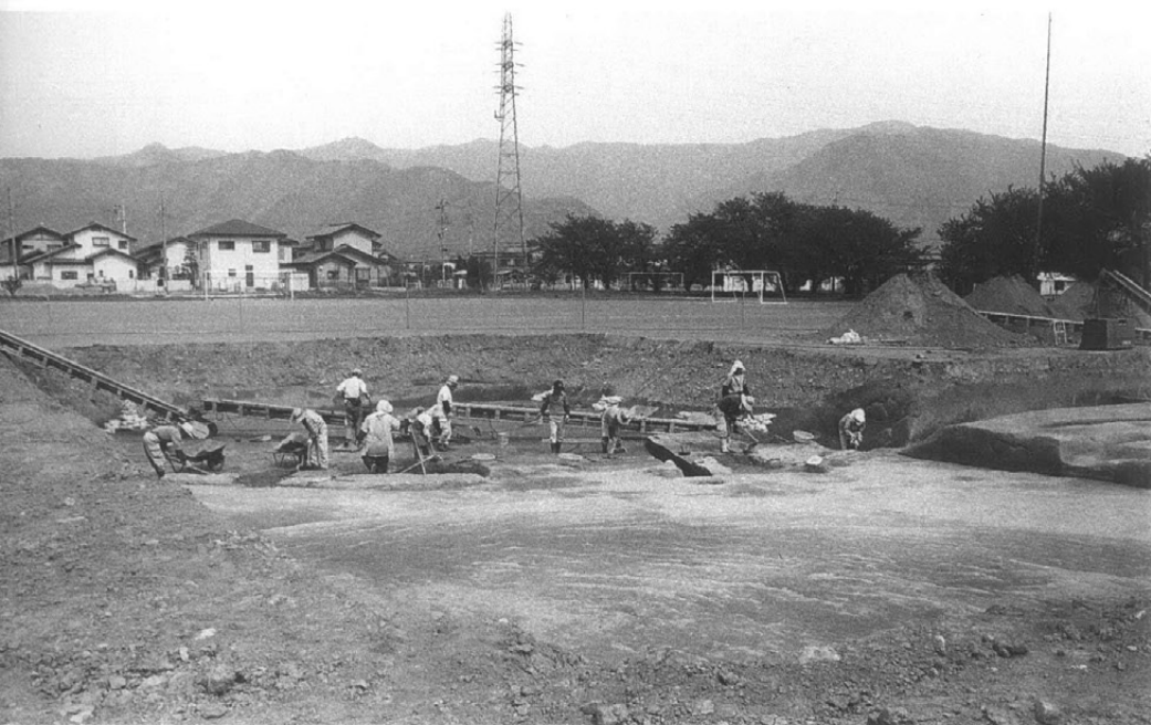
調査風景 (西側より)
