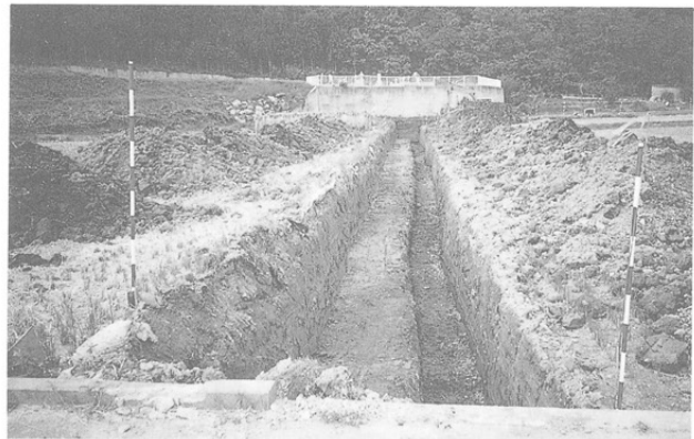
トレンチ検出状況 (東より)
