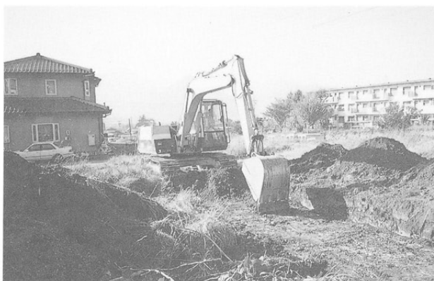
3号トレンチ掘削状況(東より)
