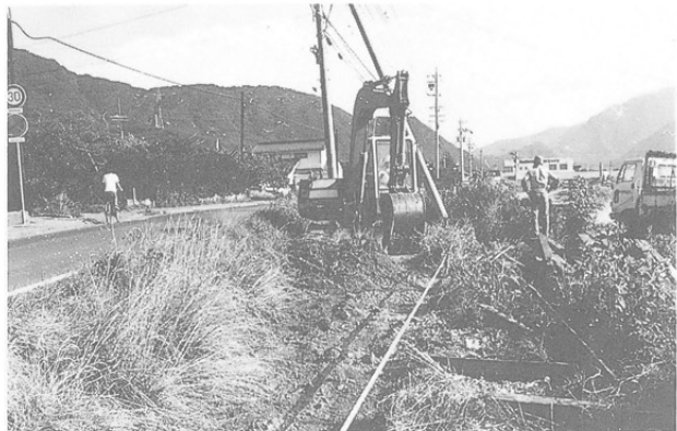
トレンチ掘削状況（北より）
