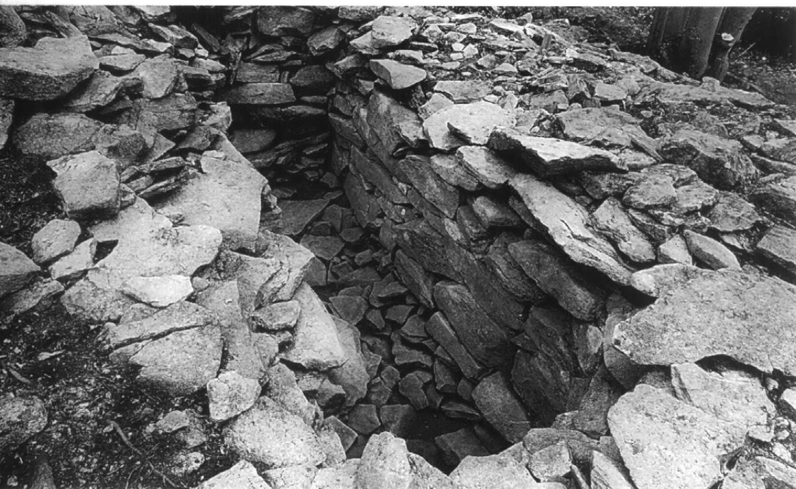
竪穴式石室 (北西より)
