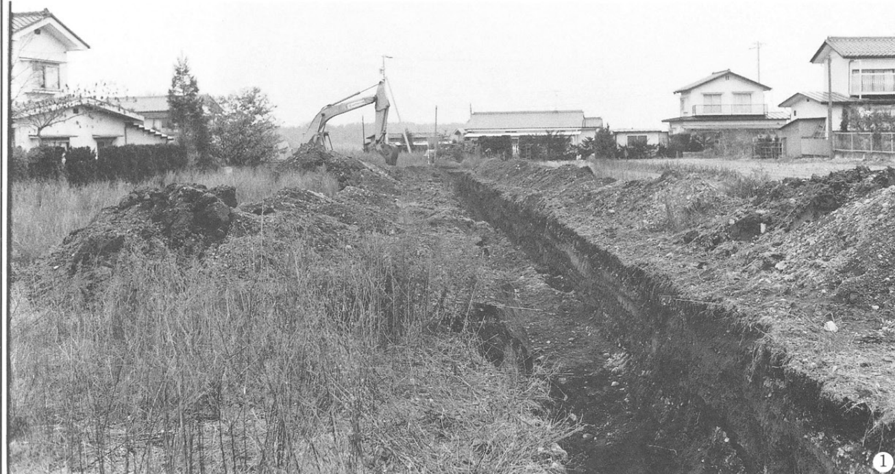
1. トレンチ調査 (南から)
