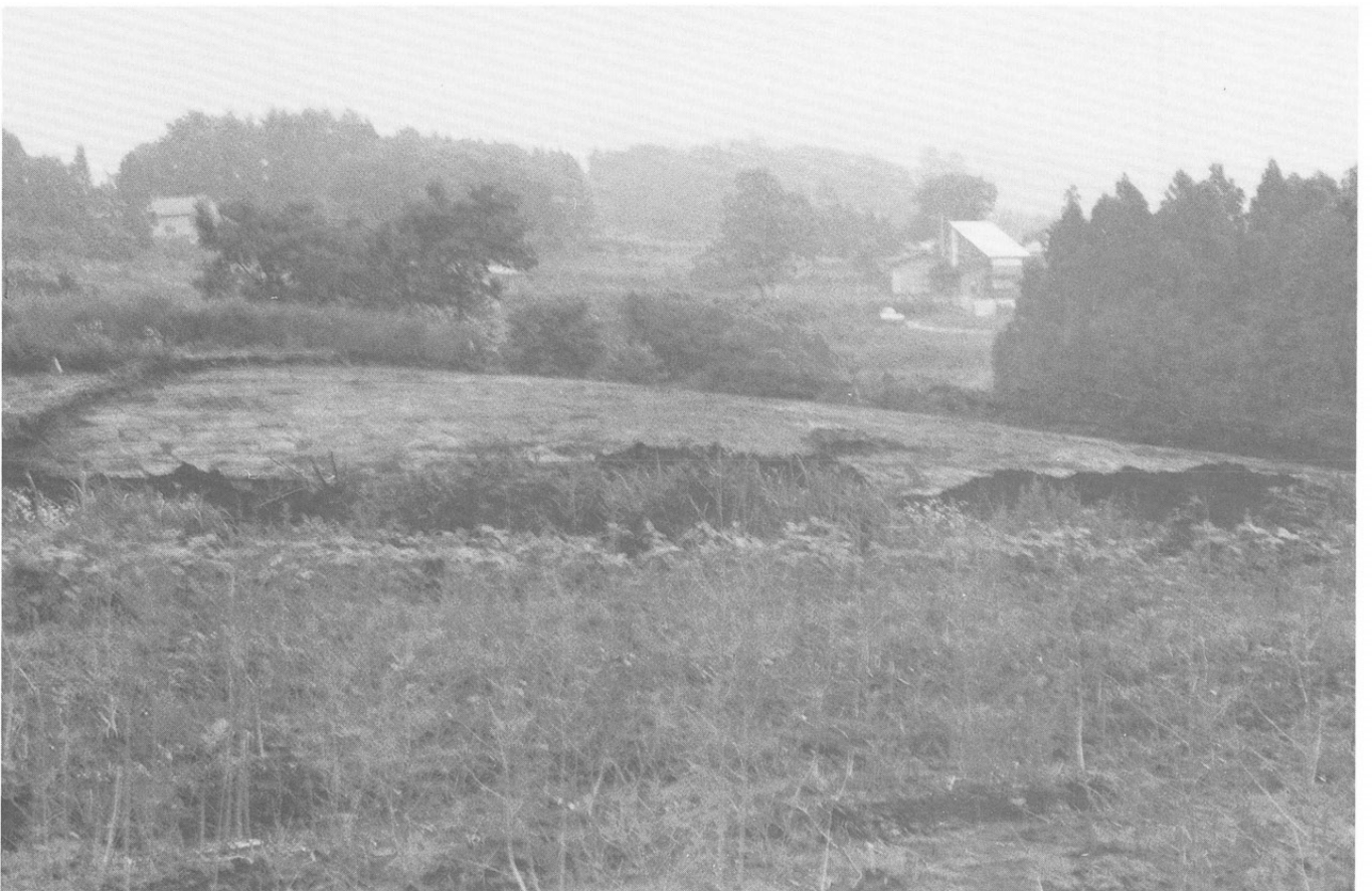
2 表土はぎ終了（西より）
