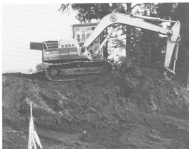
2 重機による表土はぎ
